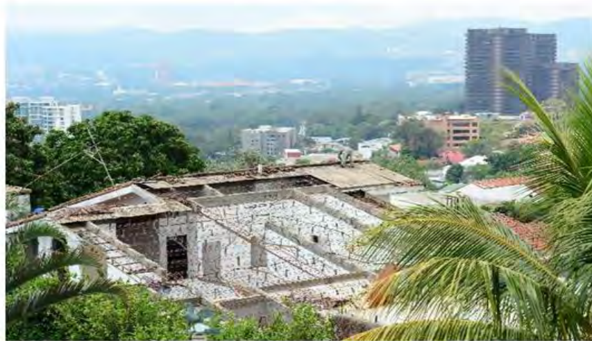
Esta es la vivienda que se está desmontando donde se construirá la torre de apartamentos. Foto EDH / Jorge Reyes
