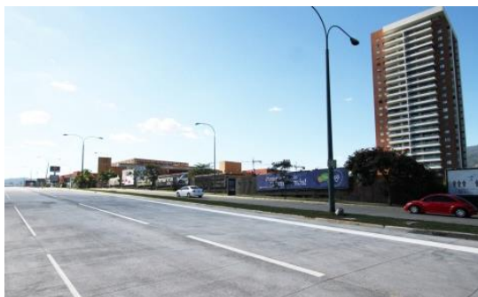
Mantenimiento periódico Carretera Panamericana
